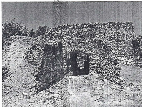
Horno doble en mal estado de conservación en Baru
