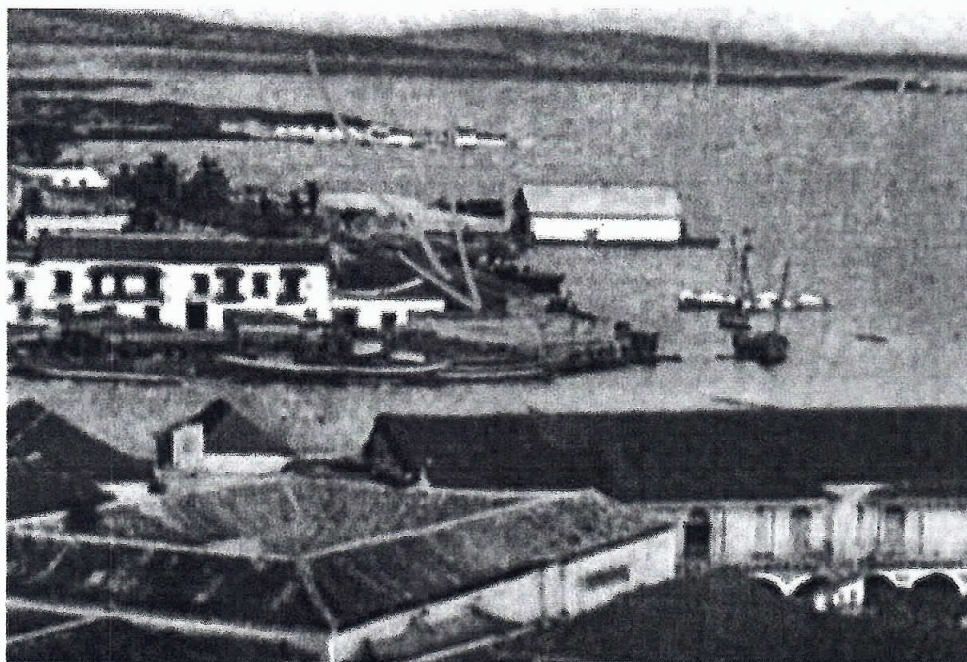
Señalados: Baluarte Barahona e Instalaciones del muelle carenero
