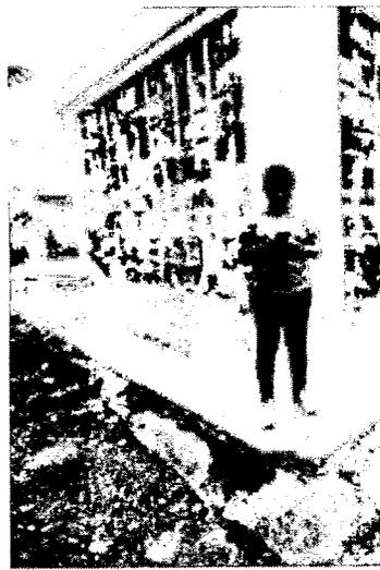
Mantenimiento y construcción de escalón para protección del andén debido a que el área se esta socavando.
