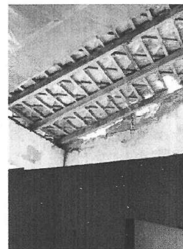
Ilustración 14 Foto cubierta existente
