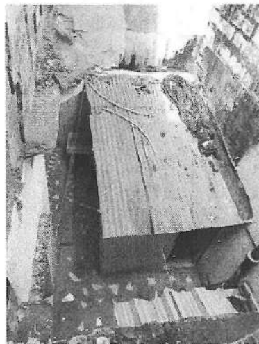
Ilustración 20 Foto construcción traspatio
