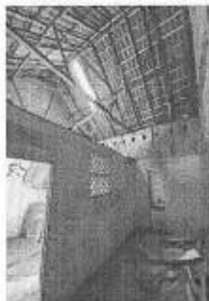
Estado de ruina a dos aguas de techo en mal estado, tipo de techo tipo paja de madera con estructura de madera, estado de ruina en algunos elementos de estructura en el caso de colado de fierro concreto y la estructura, agrietados en paredes, desplazamiento de agua al interior, se observa deterioración de algunos muros de pared de muros, ausencia de pintura y de acabado de piso.
