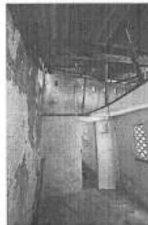
Estado de ruina de la estructura de concreto, ausencia de pintura y presencia de agua al interior, se observa deterioración de algunos muros de pared de muros, ausencia de pintura y de acabado de piso.
