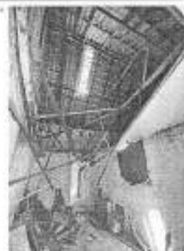
Se observa el estado de ruina de la estructura de concreto, ausencia de pintura y presencia de agua al interior, se observa deterioración de algunos muros de pared de muros, ausencia de pintura y de acabado de piso.
