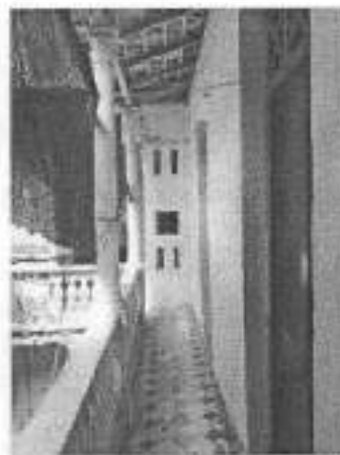
Ilustración 22 Foto corredor segundo piso
