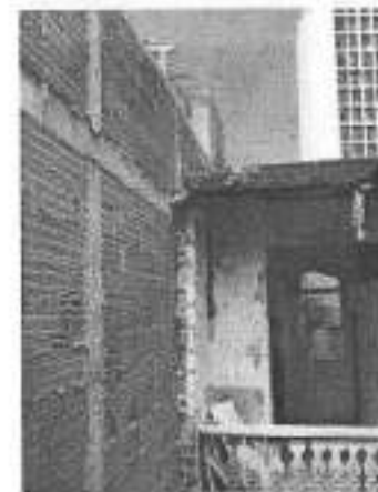
Ilustración 12 Foto culata lateral de vecino segundo piso
