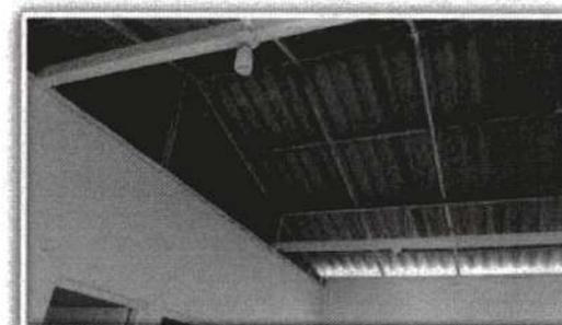
**VISTA 4:** Cubierta en asbesto cemento interior del inmueble.
