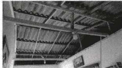
Cubierta en lamina de asbesto cemento y estructura en madera, en regular estado y presenta filtración.
