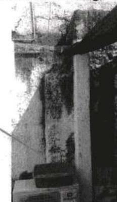
Muros perimetrales del patio, con alto estado de humedad.
