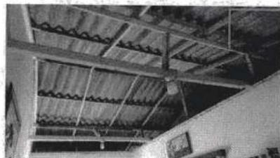
Cubierta en lamina de asbesto cemento y estructura en madera, en regular estado y presenta filtración.
