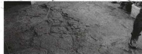
Estado actual del piso en plantilla de cemento deteriorada de la zona del patio.
