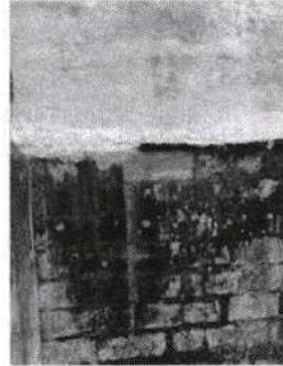
IMG 003 Muro perimetral lateral derecho en patio posterior, en levante de bloque de concreto es sin pañete, en la parte superior muro vecino con pañete
