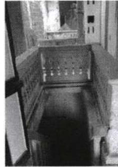
IMG 003 Entrega de escalera en segundo piso, por abertura realizada a la placa junto a la cruja del núcleo básico
