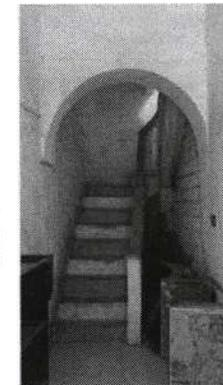
IMG 007 Acceso a segundo piso por escalera en concreto del tipo XIS con cemento pulido y pintura
