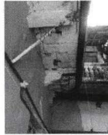
IMG 004 En esta imagen se evidencia el estado actual de las placas de los balcones del patio central en el segundo piso, mostrando la composición e la viga de concreto acanalada, también se evidencia el refuerzo estructural con una viga IP 300
