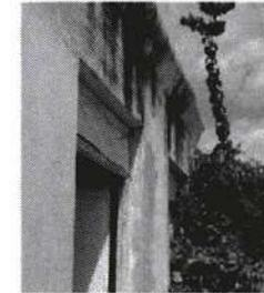
IMG 009 fachada segundo piso, en esta se evidencia la falta de cornisa, en cambio se visualiza un rediseño en cemento sobre manta asfáltica
