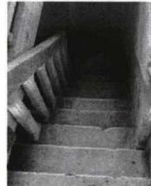
IMG 005 Escaleras con pasos en cemento pulido, se evidencian diferentes fisuras superficiales
