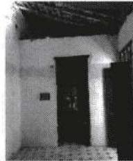
IMG 003 Muros divisorios del segundo piso en levante de bloque de concreto vibrado sin relleno en la parte superior
