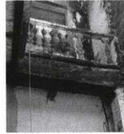
IMG 005 En esta imagen se muestran el estado de deterioro del balcón de segundo piso hacia el núcleo básico, demostrando el deterioro por los elementos que componen la Balaustrada
