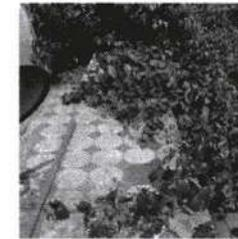
IMG 010 la placa del balcón cuenta con tableta de 20 X 20 y su estructura se evidencia con fisuras deterioro por los elementos
