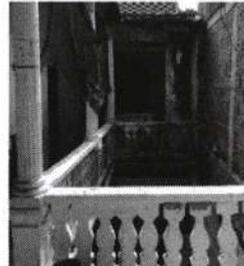
IMG 004 Balaustras en concreto con separaciones de 3cm. El conjunto de elementos del balcón deteriorados por los elementos
