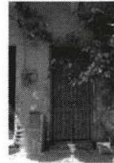
IMG 007 puerta de acceso a piso I con reja en hierro forjado y puerta en madera de dos hojas y fijo superior, dintel en madera
