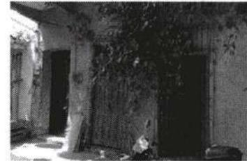
IMG 008 conjunto de puertas en fachada con dintel en madera y puertas de dos hojas y fijo en la parte superior, con rejas en acero con corrosión y deterioro por los elementos
