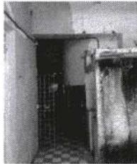
IMG 002 Acceso a patio central, muros del núcleo básico hasta primer piso es en mampostería cúbica, de segundo piso en adobe en su bloque de cemento
