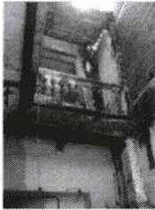
IMG 001 Viga de refuerzo en acero IP 300 empotrada en muros perimetrales para dar refuerzo al balcón del patio central
