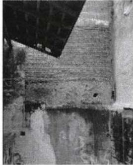
IMG 001 Muro Colindante posterior del predio, con pañete hasta el piso 2 con signos de humedad y deterioro, en la parte superior levante de muro en pañeta militar sobre bloque cerámico
