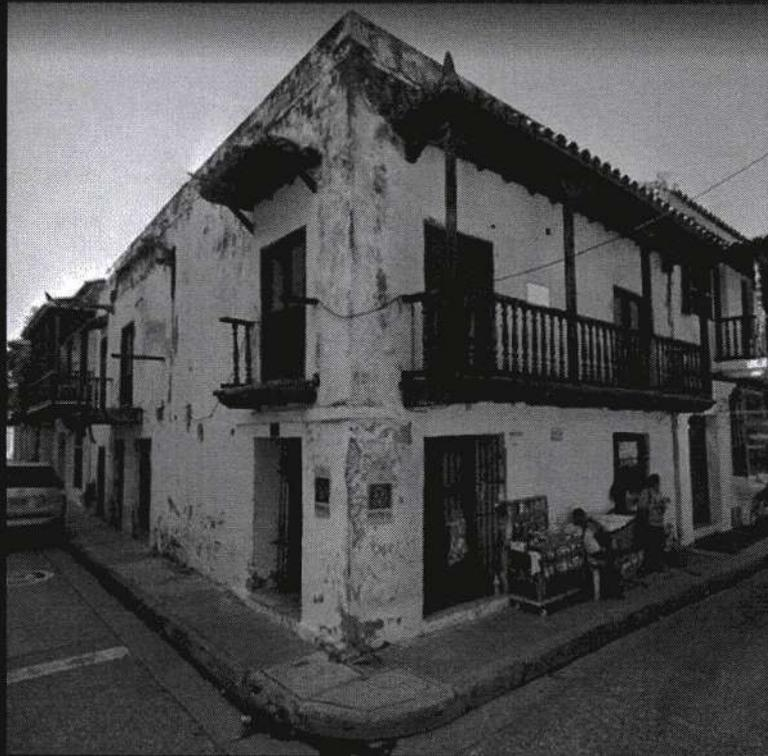
Fachada en deterioro. Se observa la pérdida de los elementos de fachada, tales como balcones y tejadillos, muros con humedades.
