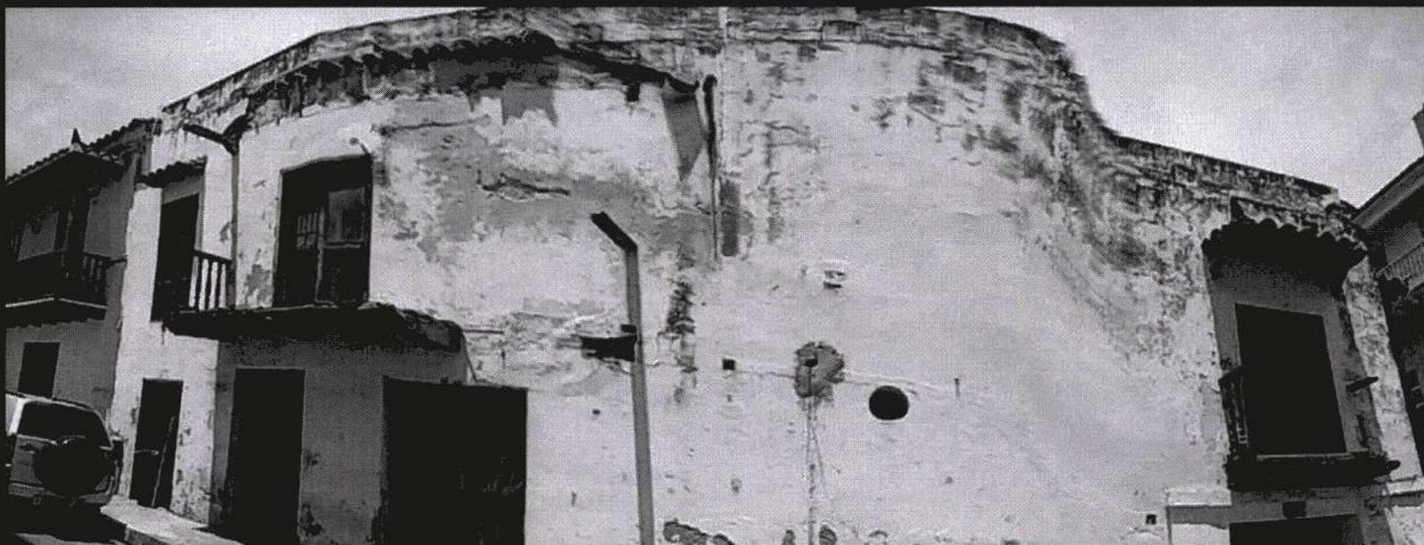
Fachada en deterioro. Se observa la pérdida de los elementos de fachada, tales como balcones y tejadillos, muros con humedades.
