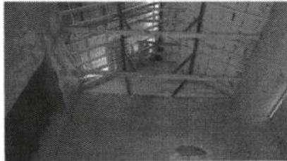
Cubierta en madera y tejá del segundo piso, la cual se encuentra deteriorada y en gran parte desmontada, con el fin de proteger la estructura de los muros de la intemperie, ésta se ha complementado utilizando laminas de Zinc.
