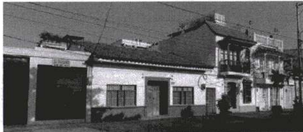
ASPECTO GENERAL DEL PARAMENTO SUR DE LA CALLE O AVENIDA DEL PEDREGAL DONDE SE OBSERVA EL PERFIL URBANO DE LA MISMA Y EN ELLA LA CASA EN ESTUDIO.
