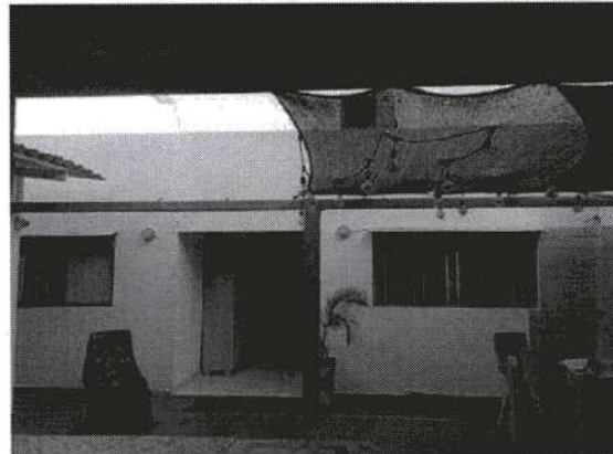
ASPECTO DE LA FACHADA POSTERIOR INTERNA DEL VOLUMEN PRINCIPAL DE HABITACIONES Y EL PASILLO CENTRAL DE ACCESO A LA CASA.
