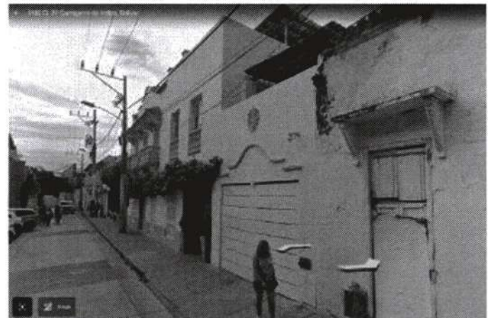
Vista del Multifamiliar en la Calle Camposanto, que colinda con el predio en estudio.
