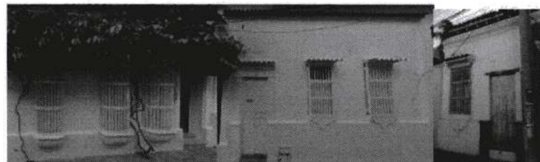
Vista de predios vecinos, que tienen la misma normativa RFA y realizaron aumentos en en crujiás de fondo en dos pisos, si afecta la fachada de la calle de la Carbonera
