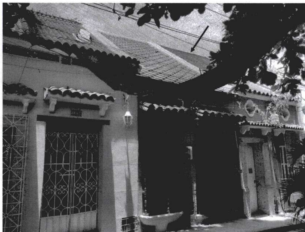
Vista de cubierta – se mantiene la altura de cumbreras
