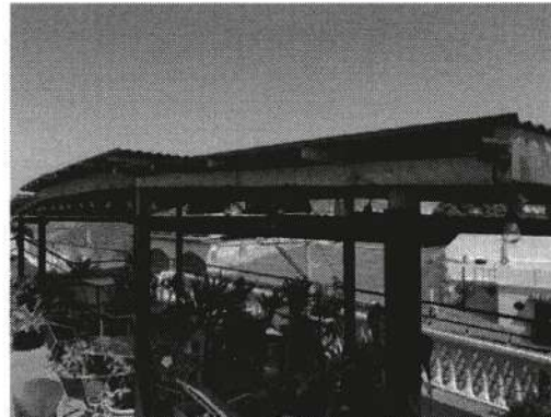
Foto. Pergola sobre cubierta
