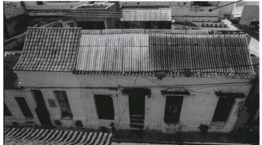
Vista de predios vecinos, con altura en crujías de fondo en dos pisos, y muro colindante del Multifamiliar en la misma manzana 107
