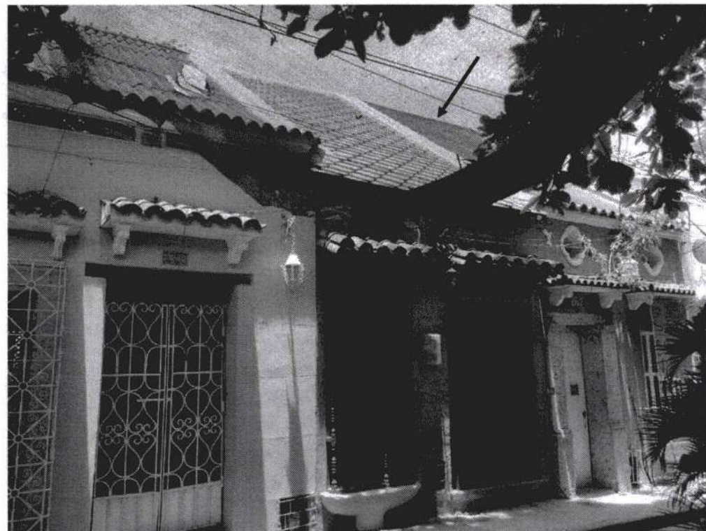
Vista de cubierta – se mantiene la altura de cumbreras
