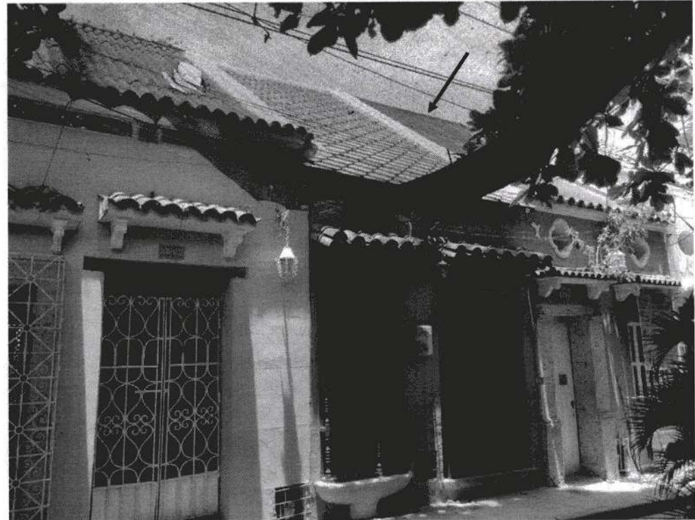
Vista de cubierta – se mantiene la altura de cumbres
