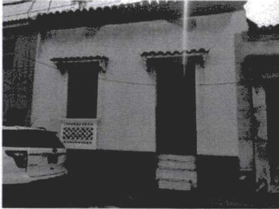
Estado Actual de la Edificación.
